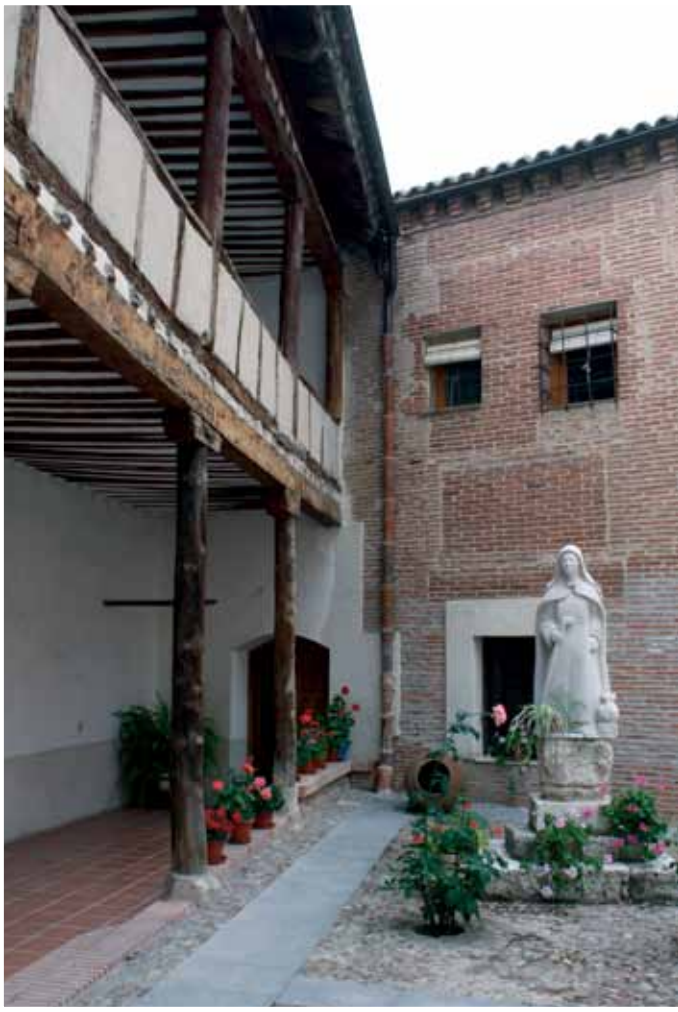
► Convento de Medina del Campo, que conserva su celda original. Convent in Medina del Campo conserving St. Theresa's original cell.
