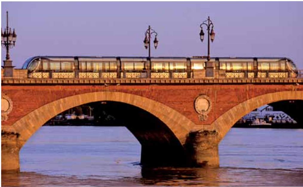
El silencioso tranvía atraviesa el Puente de Piedra. A tram silently crossing the Pont de Pierre. © François Poincet
